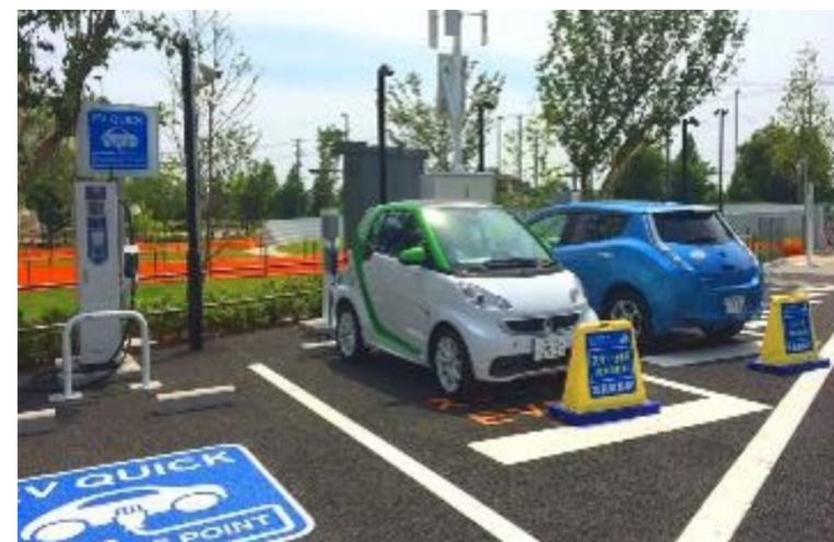
EV充電システム
